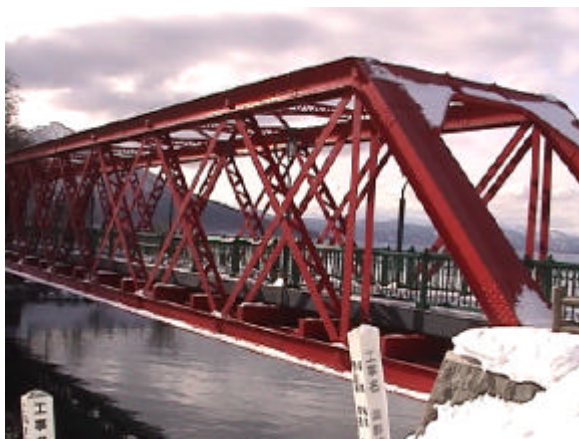
図5 北海道支笏湖にある山線鉄橋
