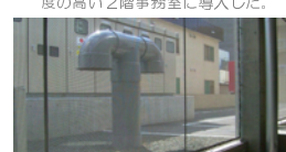
クール&ヒートチューブによる定温空気の供給：外気温（入口温度）と室内取入温度の変化を測定。外気温の変動の影響が小さく安定した温度の空気を供給できている。
