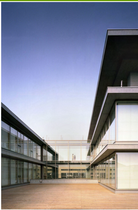
南側ルーフトバルコニー、渡り廊下
