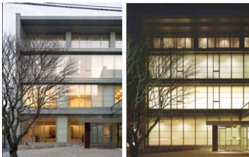
アプローチ外観：障子オープン
