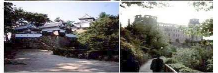
備中松山城も修復と復元が進められている
