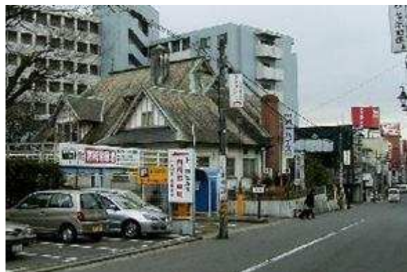
旧中埜家住宅は洋館建築として美しいが、看板類に埋没して景観としては美しい
