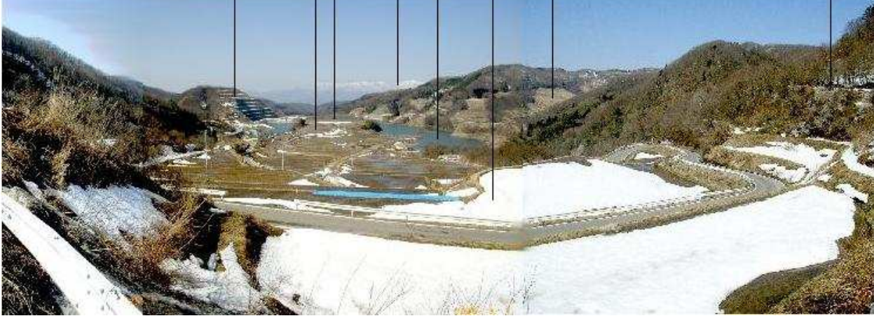
●小倉ダム湖上流からの全景 2006年3月7日
